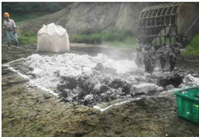
ボンファイバー攪拌状況
