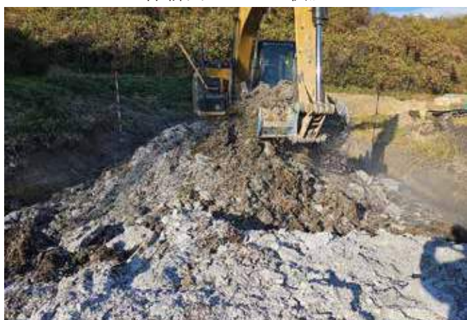
原位置攪拌状況
