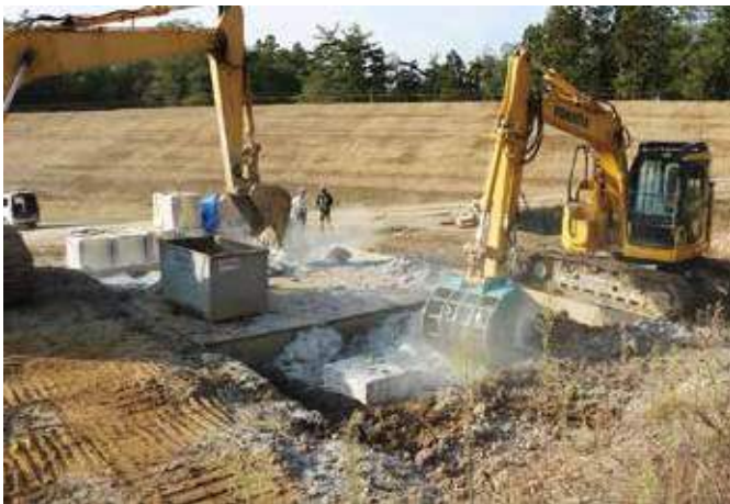
ボンファイバー攪拌状況
