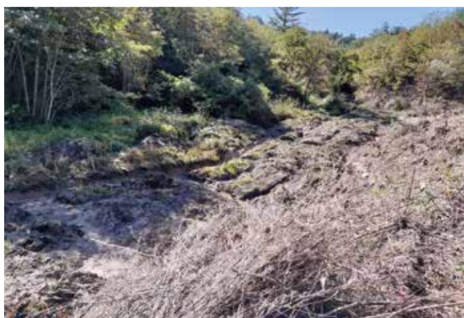
休耕田工事着工前
