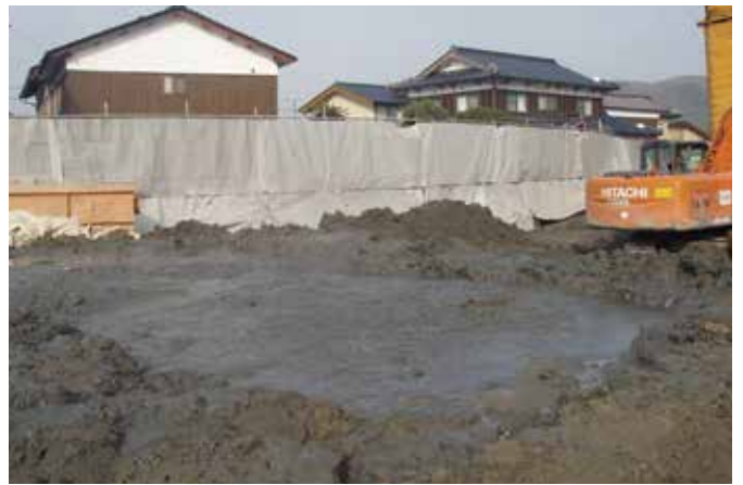
CDM 泥土排出状況
