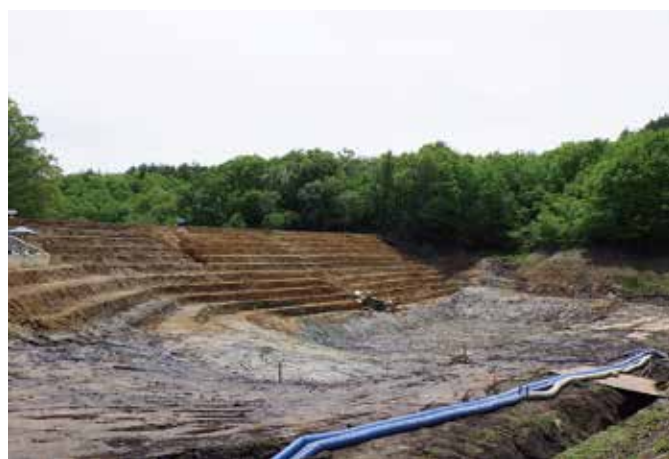
既設堤体段切り状況
