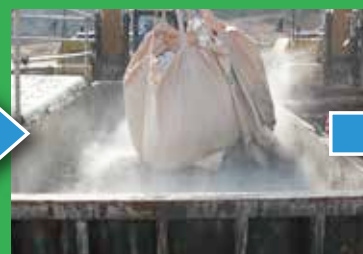
固化材投入・攪拌
