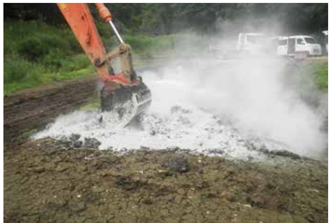
固化材攪拌状況
