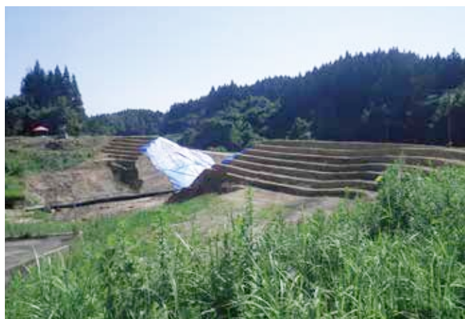
既設堤体段切り状況
