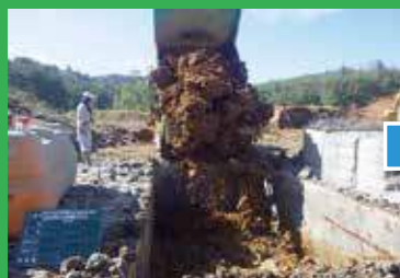
攪拌ピットに泥土投入
