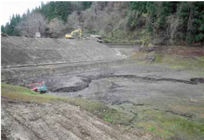
底泥土の堆積状況
