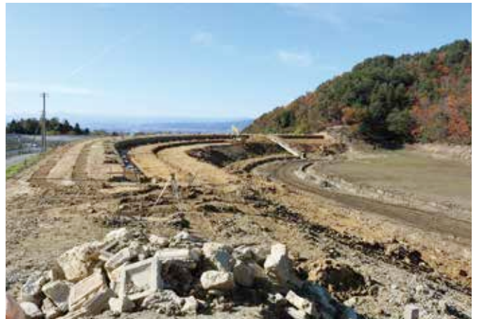
既設堤体段切り状況
