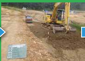
養生日数経過後、敷均し・転圧
