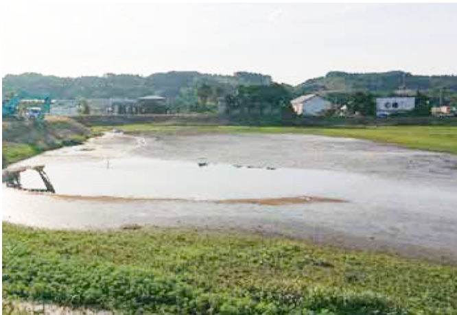
底泥土の堆積状況
