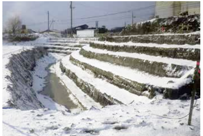
既設堤体段切り状況
