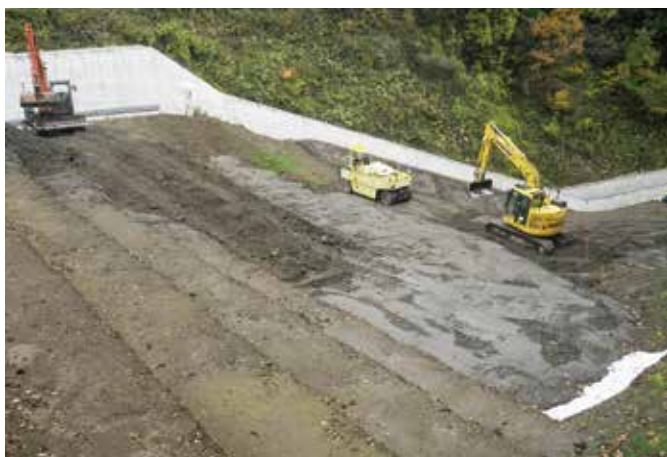
敷均し締め固め状況
