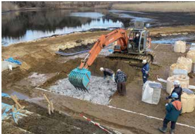
現位置攪拌状況
