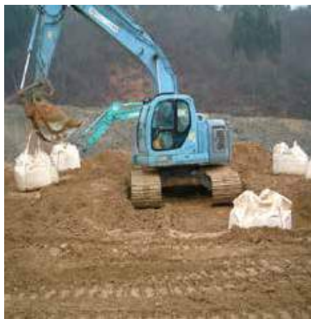
固化材添加状況
