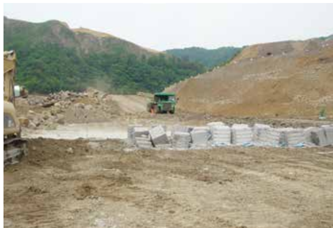
工事用道路に再利用
