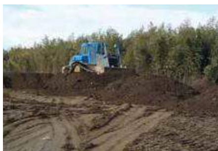
敷均し・転圧
