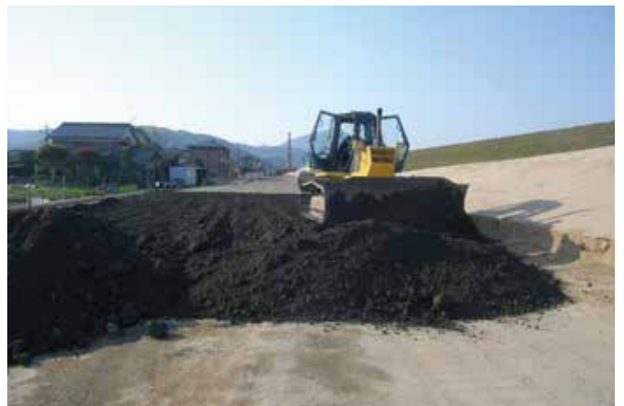
ポンテラン改良土敷均し状況
