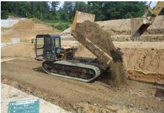
改良土運搬状況
