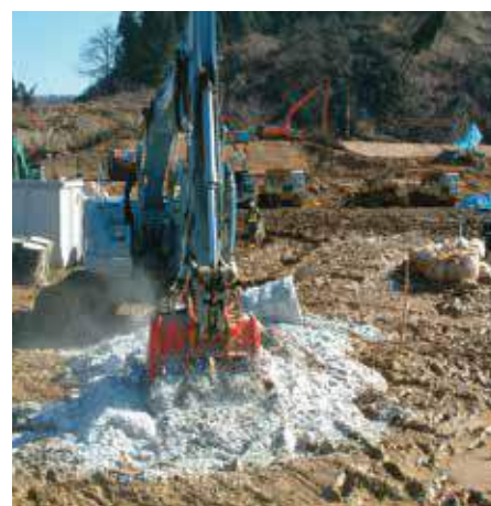
ボンファイバー攪拌状況
