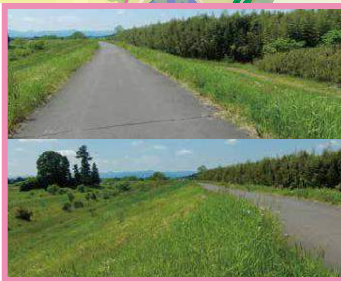
【震災後、ポンテラン改良土を用いた施工箇所】 被害無し
