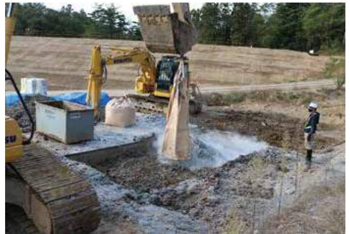
固化材投入状況
