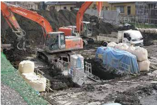
改良状況全景
