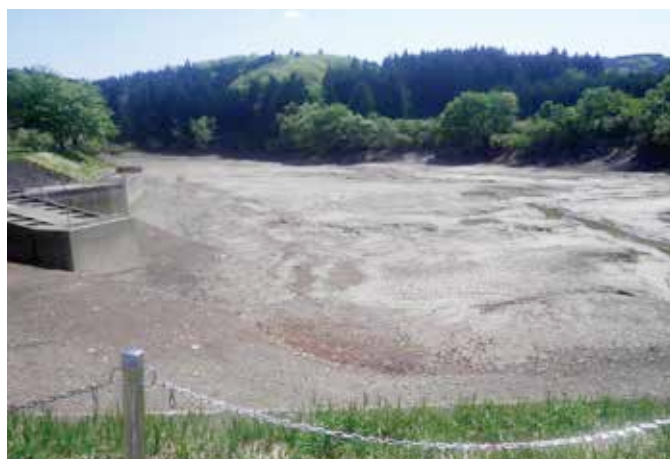
底泥土の堆積状況
