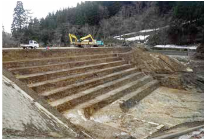
既設堤体段切り状況
